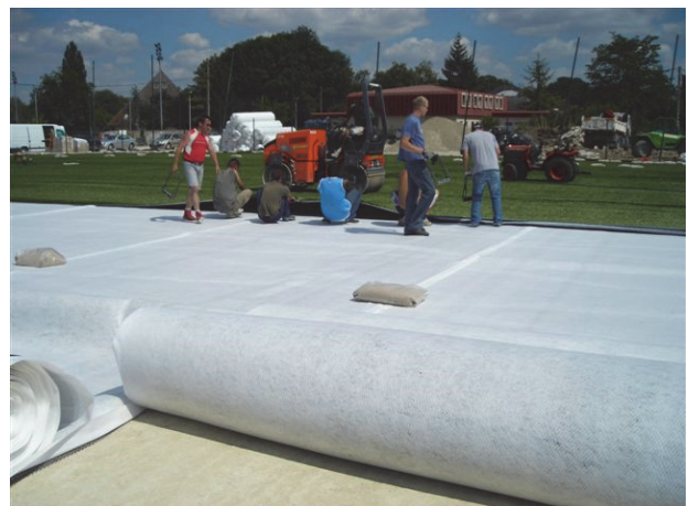
Figure 14 : Géosynthétique de drainage sous gazon synthétique (Terrain de sport)
