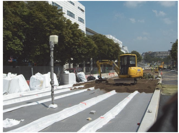
Figure 16 : Géosynthétique de drainage sous terre végétale (Tramway)
