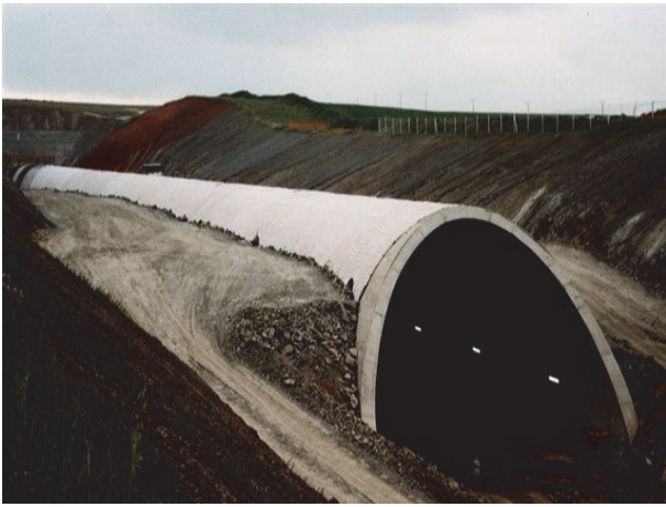
Figure 9 : Géosynthétique de drainage autour d'un tunnel
