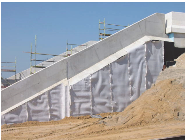
Figure 7 : Géosynthétique de drainage contre un mur d'ouvrage d'art
