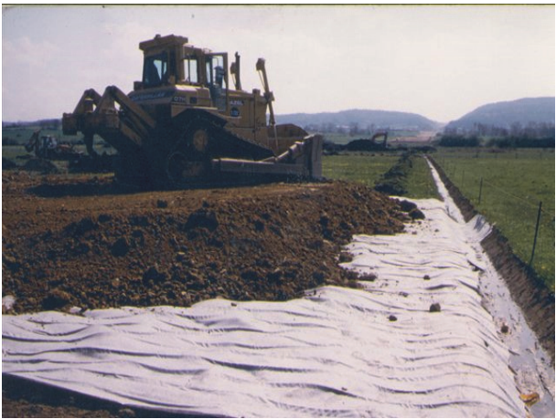
Figure 5 : Géosynthétique de drainage sous remblai
