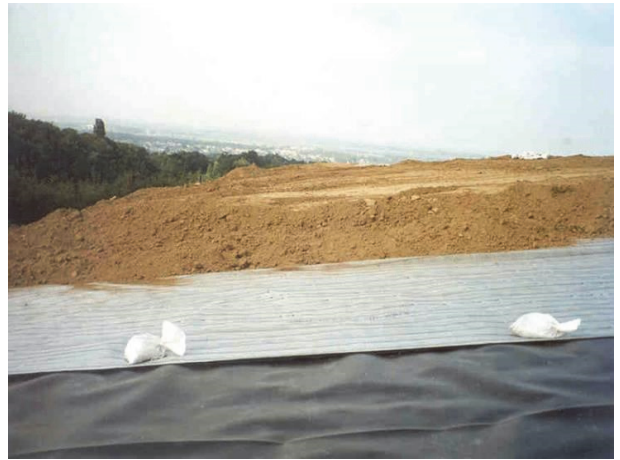
Figure 12 : Géosynthétique de drainage au-dessus de l'étanchéité en couverture d'Installation de Stockage de Déchets
