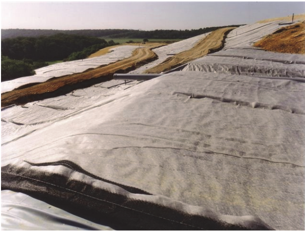
Figure 11 : Géosynthétique de drainage en couverture d'Installation de Stockage de Déchets
