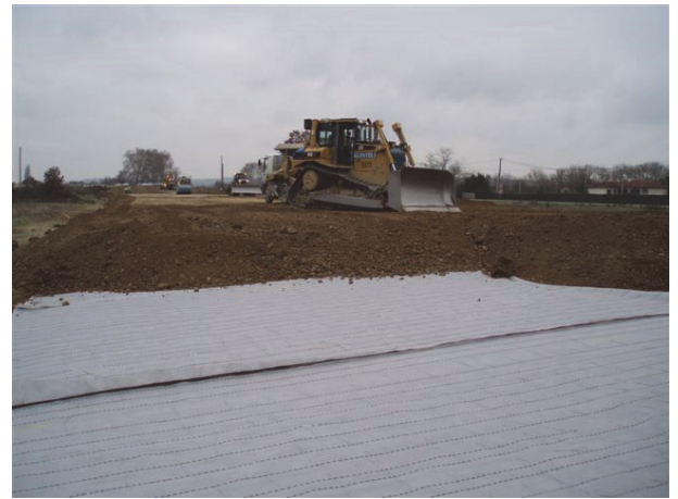
Figure 6 : Géosynthétique de drainage sous remblai
