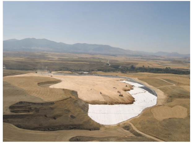
Figure 10 : Géosynthétique de drainage en couverture d'Installation de Stockage de Déchets
