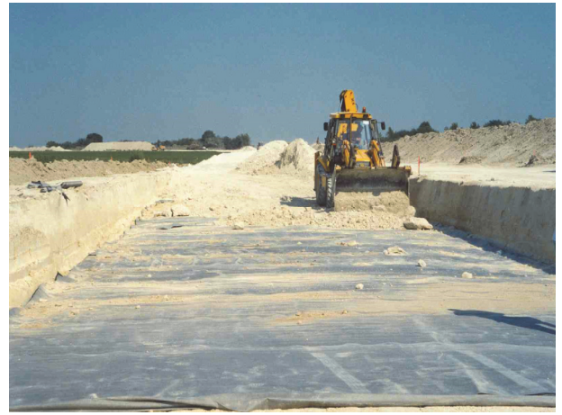
Figure 4 : Géosynthétique de drainage sous couche de forme
