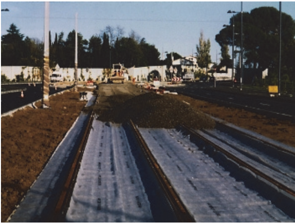
Figure 15 : Géosynthétique de drainage sous terre végétale (Tramway)
