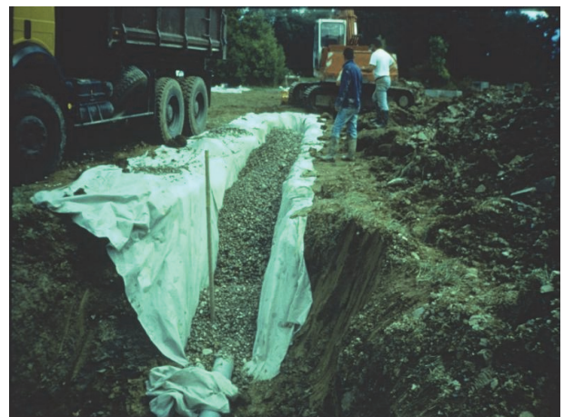
Figure 2 : Filtre géotextile en tranchée drainante
