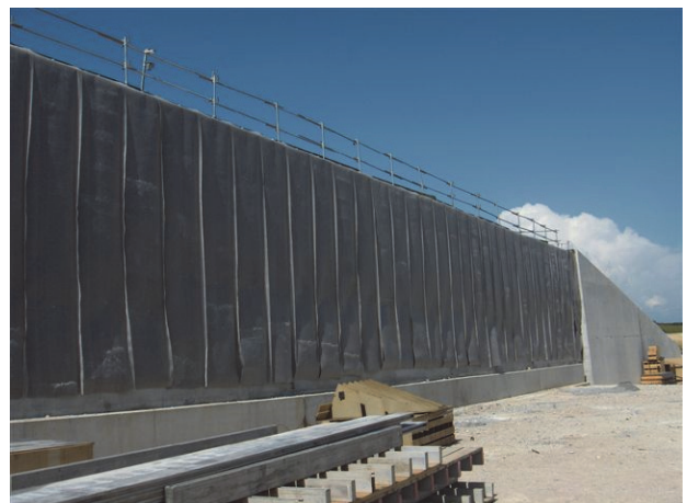
Figure 8 : Géosynthétique de drainage contre un mur d'ouvrage d'art
