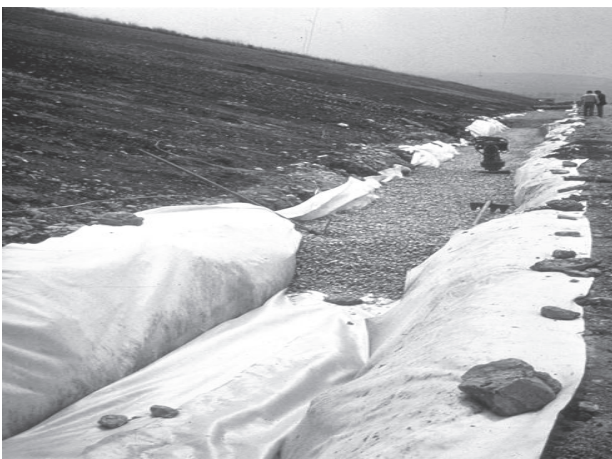
Figure 1 : Filtre géotextile en tranchée drainante
