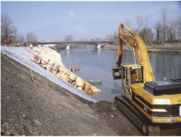
Figure 3 : Filtre géotextile en protection de berge
